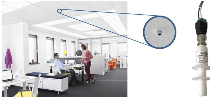
Les senseurs doivent être branchés avec un câble de cuivre 2-conducteurs Blindé, grosseur 22 AWG ou plus gros. Jusqu'à 6 senseurs peuvent être branchés sur une entrée active. Connectez le câble de blindage (Shield) sur le terminal négatif aux contrôleurs. Si plusieurs senseurs sont branchés sur une même zone, assurez-vous que le blindage soit continu d'un senseur à l'autre.
